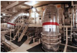
主蒸気ノズル
