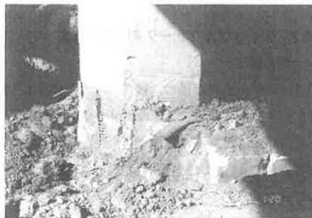
写真 5.5.31 RP2-2 橋脚基礎の損傷<sup>2)</sup>
