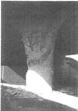
写真 5.5.30 LP2-2 橋脚の被害 (かぶりコンクリートの剥離) (コアコンクリートを拘束する帯鉄筋とは別に、フレア部を補強する鉄筋が見える)<sup>2)</sup>
