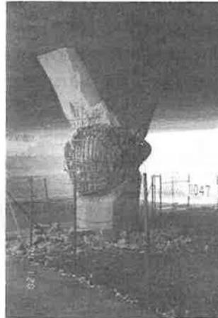
写真 5.5.29 LP3-2 橋脚の被害 (曲げせん断破壊が進み、軸線が完全にずれている)<sup>2)</sup>
