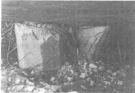
写真 5.5.26 RP3-1 橋脚の被害<sup>2)</sup> (フレアの直下で破壊している)
