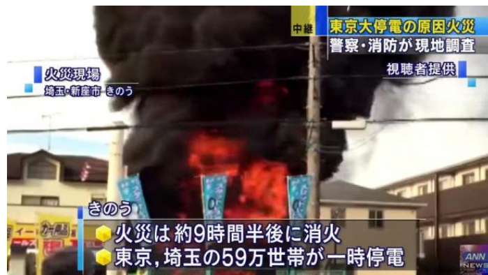
「東電地下送電設備のOFケーブル火災」を伝えるテレビ朝日のニュースより
