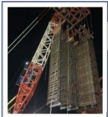
外枠部分(地中連続壁部の溝)に入れる鉄筋かご(写真1)
