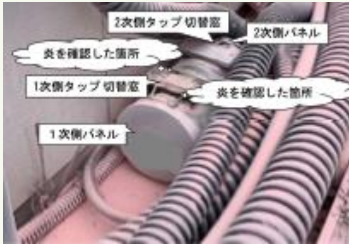
変圧器の水没
