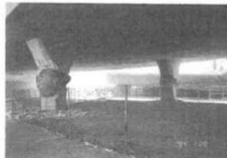
写真 5.5.28 LP3-1 橋脚の被害 (曲げせん断破壊)<sup>2)</sup>
