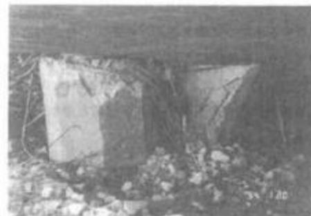
写真 5.5.26 RP3-1 橋脚の被害<sup>2)</sup> (フレアーの直下で破壊している)
