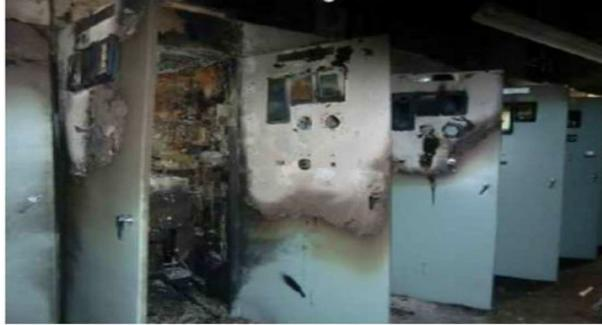
女川1号機では、異なる2台の降圧電源盤でアーク放電が発生し、連続する10台の高圧電源盤にケーブルダクトを通じて損傷が広がった。この損傷及びその後の火災によって安全系の残留熱除去系ポンプが一時停止するという二次的な事象も発生！
